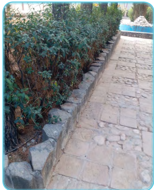
شکل ۹- کاربرد منشورهای بازالتی گوربد سریشه در جداول فضای سبز کنار خیابان و محوطه‌ها در شهر بیرجند
